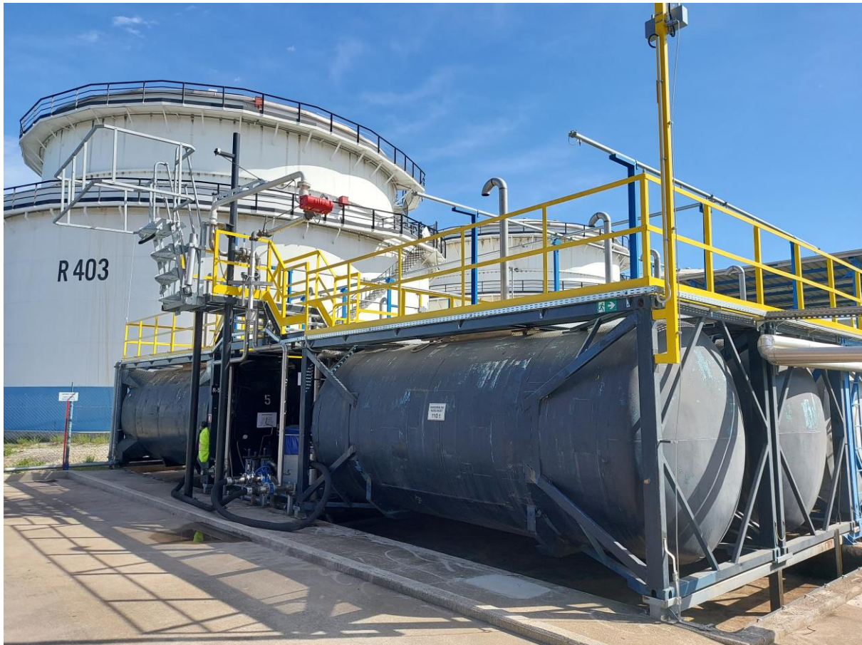
Slika 9: Objekt kalužnica s šestimi 24 m 3 rezervoarji in dvema 21 m 3 rezervoarjema.
